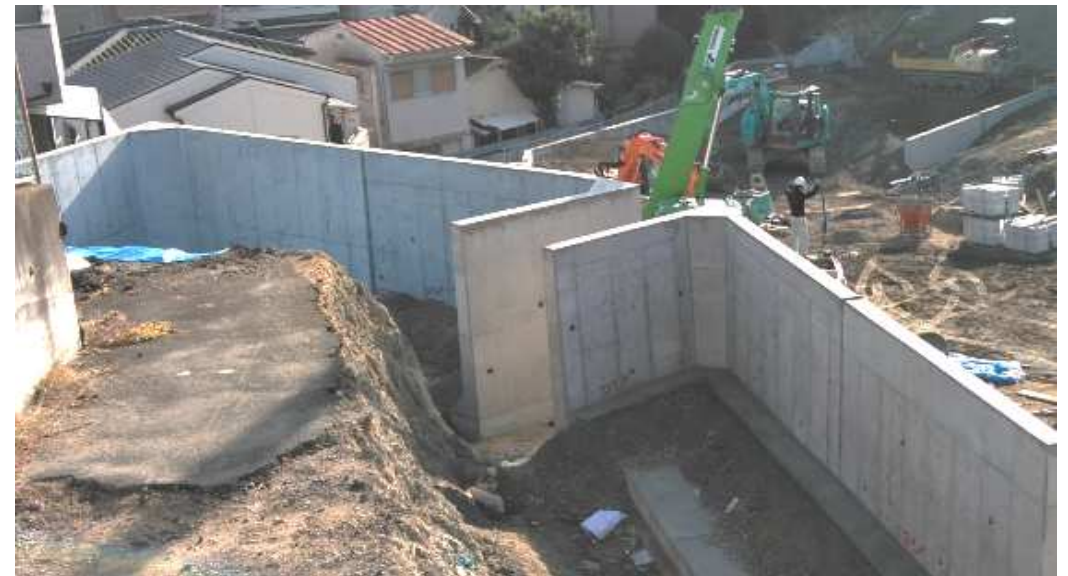
「豊中栗ヶ丘 宅地造成工事」2020年12月時点現況
